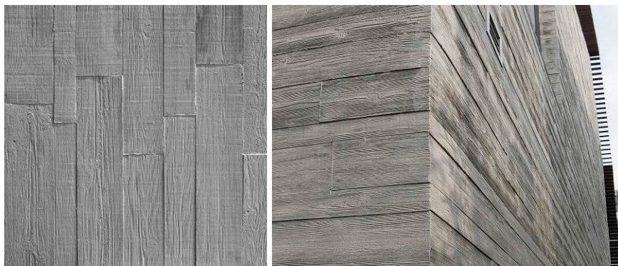
Obr. Pohledový beton s výrazným otiskem vertikální prken
